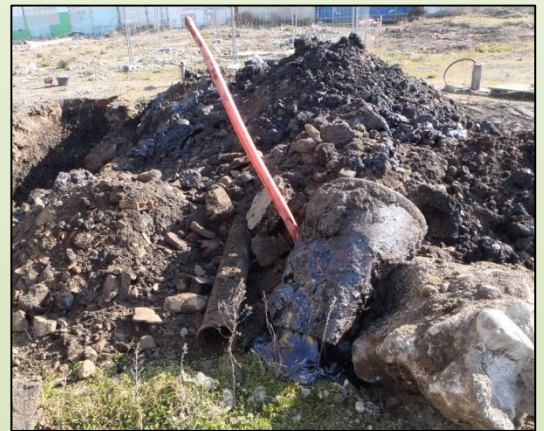
Vérification des anomalies identifiées par des sondages à la pelle mécanique
