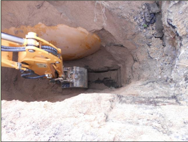
Mise au jour d'un ancien réservoir de stockage d'hydrocarbures de 10 m 3
