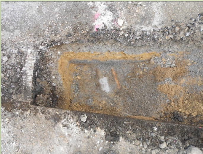
Mise au jour des réseaux détectés
