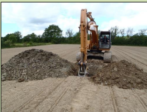
Vérification des hypothèses géophysiques par des sondages à la pelle mécanique
